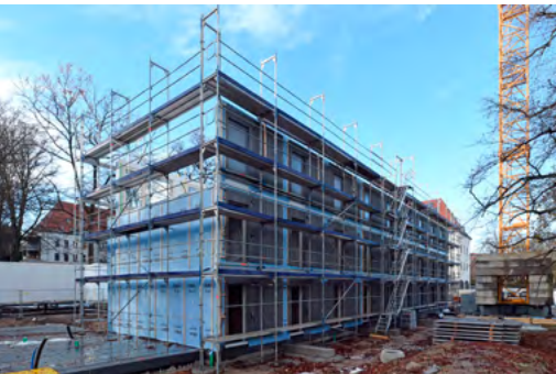
Seit November 2024 werden die vorgefertigten Holzbau-Elemente aufgerichtet
