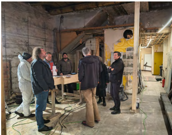
Eine der zahlreichen Besprechungen auf der Baustelle. Foto: Birgit Kata, Kempten
