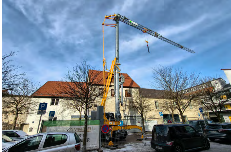
Der Kran beliefert die Baustelle im Beginenhaus von der Burghaldegasse aus. Foto: Birgit Kata, Kempten
